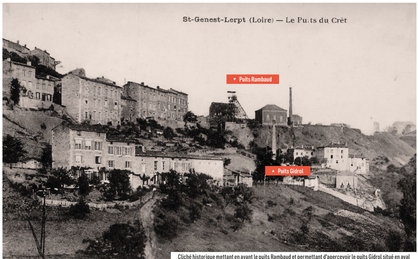
Cliché historique mettant en avant le puits Rambaud et permettant d'apercevoir le puits Gidrol situé en aval
