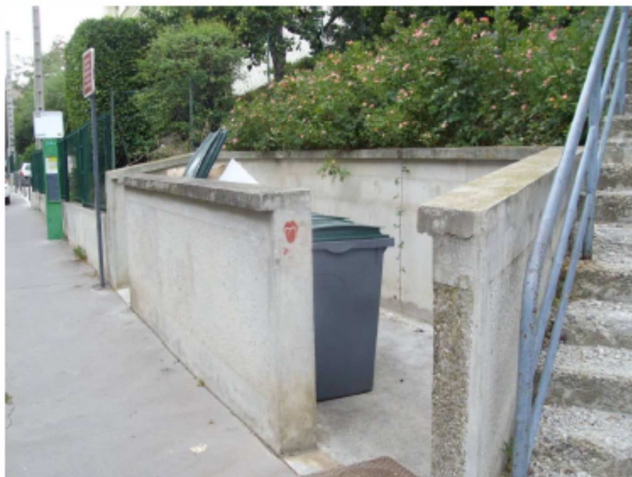
Dalle béton + mur
