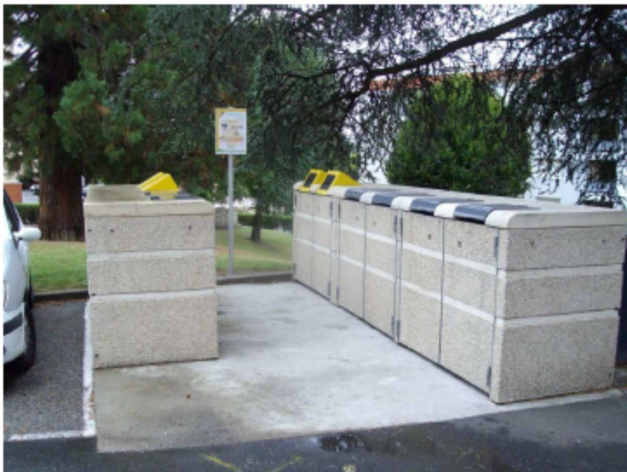
Abri préfabriqué + dalle + panneau de consignes
