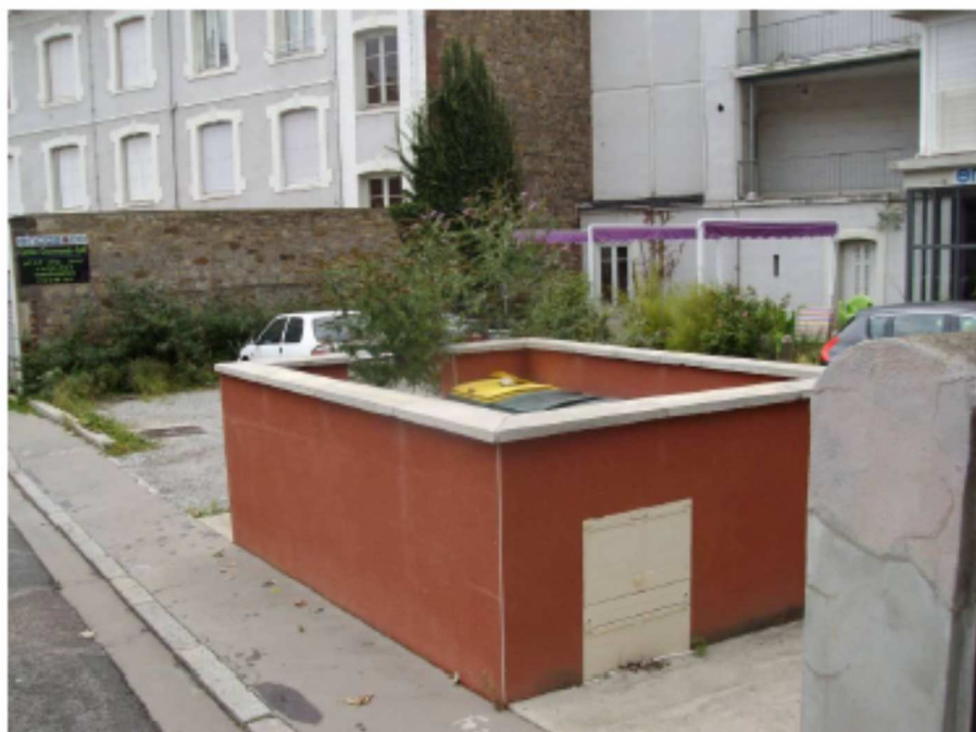
Enclos maçonnerie (comprenant point d'eau)
