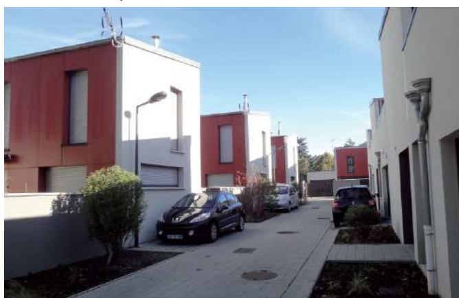
Chaussée traitée comme un espace mixte piéton / voiture avec stationnement longitudinal à certains endroits (sens unique de circulation).
