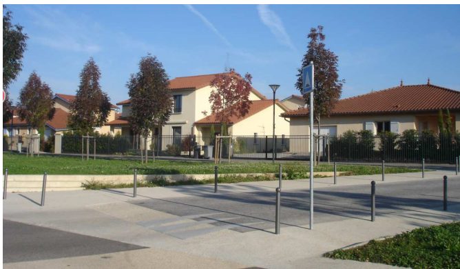
Trottoirs de part et d'autre de la voie principale du lotissement (double sens de circulation). Les trottoirs sont au même niveau que la voirie pour un plus grand confort d'usage (piéton / véhicules techniques).
