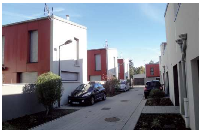
Chaussée traitée comme un espace mixte piéton / voiture avec stationnement longitudinal à certains endroits (sens unique de circulation).
